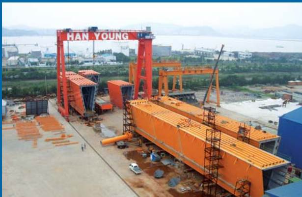
▲ 공장 P.E. 작업 전경
