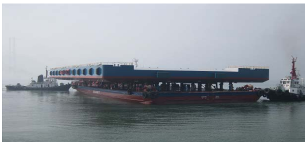
▲ PONTOON 해상운송(광양 컨테이너항 접안 대기) 전경
