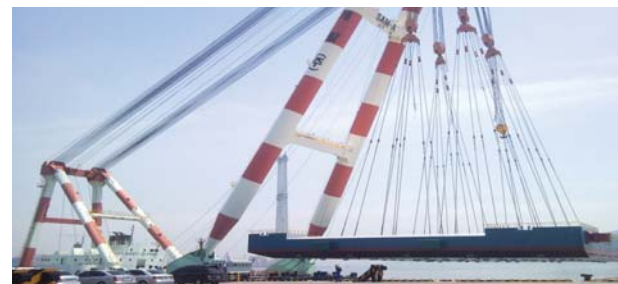
▲ PONTOON 하역/진수(삼아 2200호 F/C 하역,진수작업) 전경
